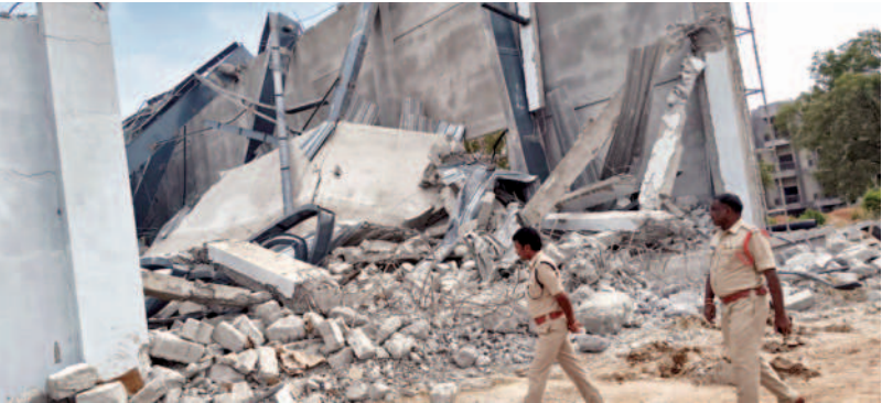
కుప్పకూలిన నిర్మాణంలో ఉన్న ఆడిటోరియం భవనం
